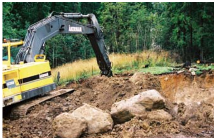
Maneesin pohjaksi on hyvä valita mahdollisimman tasainen rakennuspaikka niin välttyään turhansuurilta maansiirtotöiltä kuten kuvan työmalla joudutaan tekemään
