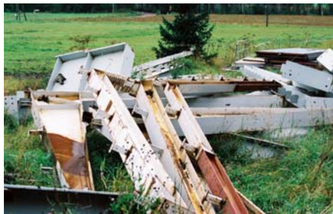
Vanhan hallinrungon ostaminen ei välttämättä ole edullinen tai hyvä tapa ratkaista maneesin runko. Runko saattaa vääntyä pahastikin purku- ja siirtotyössä eikä se oikein sovi pihankoristeeksi.
