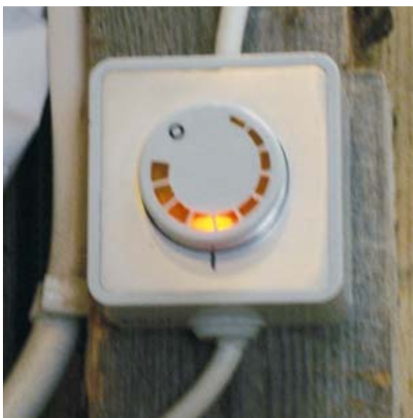
Poistoilmapuhaltimen portaaton säädin, jolla voi itse säätää haluamansa voimakkuuden ilmanvaihtoon.
